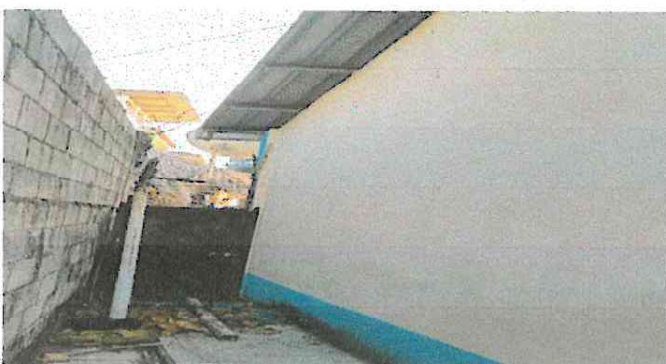
Foto 3: Reparación de muro perimetral de block ( soleras intermedias y columnas
