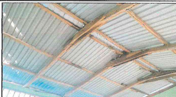
Foto1: Sustitución de lámina acanalada , por lámina troquelada area de DIRECCIÓN
