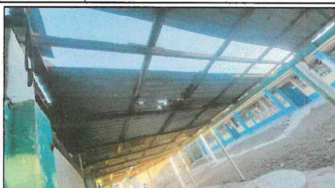
Foto 2: sustitución de estructura de soporte (madera, metal) por metal area de galera
